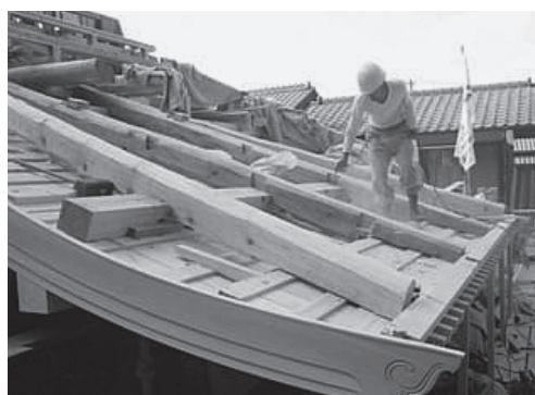
桔木（はねぎ、天秤梁）施工
